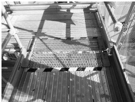
写真-5 通路の養生②
