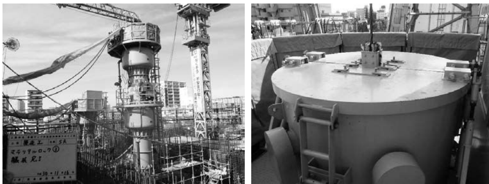
写真-13 ワイヤーボックス消音装置と防音マットによる騒音対策
