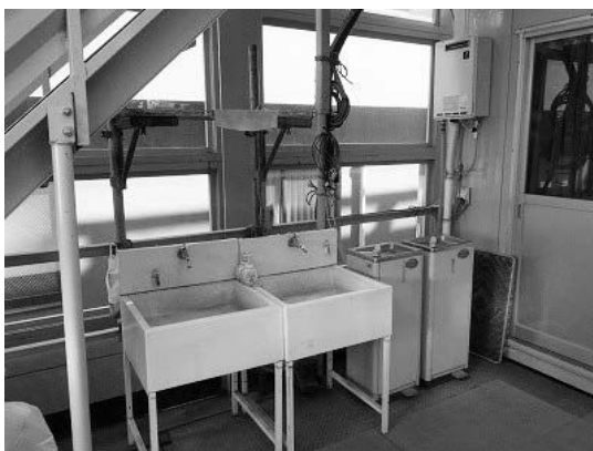
写真-19 給湯器や衛生製品が設置されている手洗場
