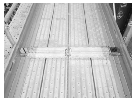
写真－4 通路の養生①
