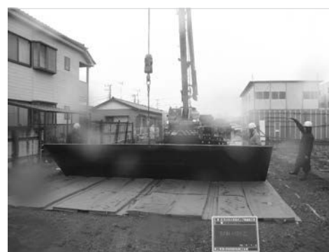
写真－11 防振マットの設置
