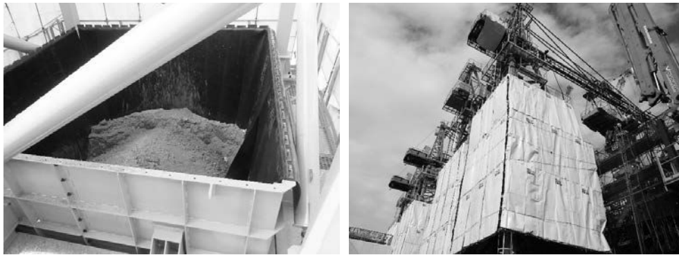
写真-12 ホッパー内ゴム板と外部防音シートによる騒音対策
