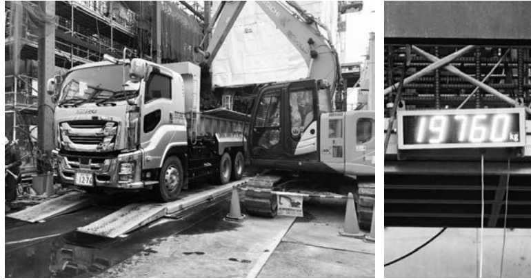
写真-18 積載量確認の様子
